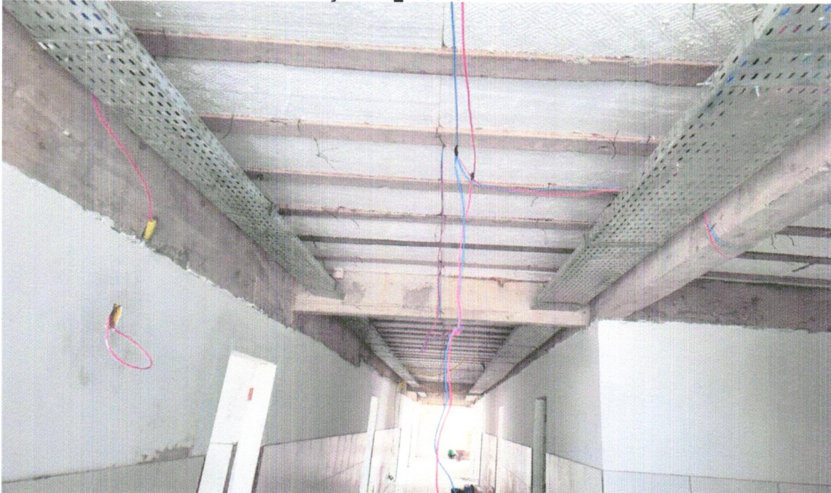
FOTO 40 - CABO DE COBRE FLEXÍVEL ISOLADO, 2,5 MM 2 , ANTI-CHAMA 450/750 V, PARA CIRCUITOS TERMINAIS - FORNECIMENTO E INSTALAÇÃO. AF_12/2015
