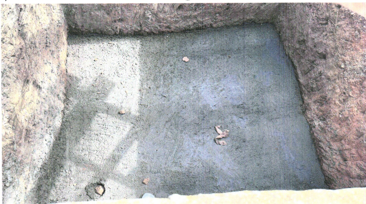
FOTO 02 - CONCRETO FCK = 25MPa, TRAÇO 1:2,3:2,7 (EM MASSA SECA DE CIMENTO/ AREIA MÉDIA/ BRITA 1) - PREPARO MECÂNICO COM BETONEIRA 400 L. AF_05/2021
