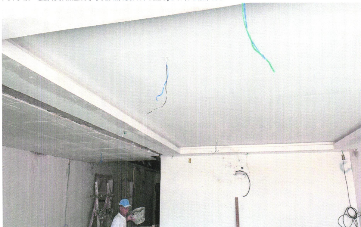
FOTO 20 - EMASSAMENTO COM MASSA A OLEO, DUAS DEMAOS
