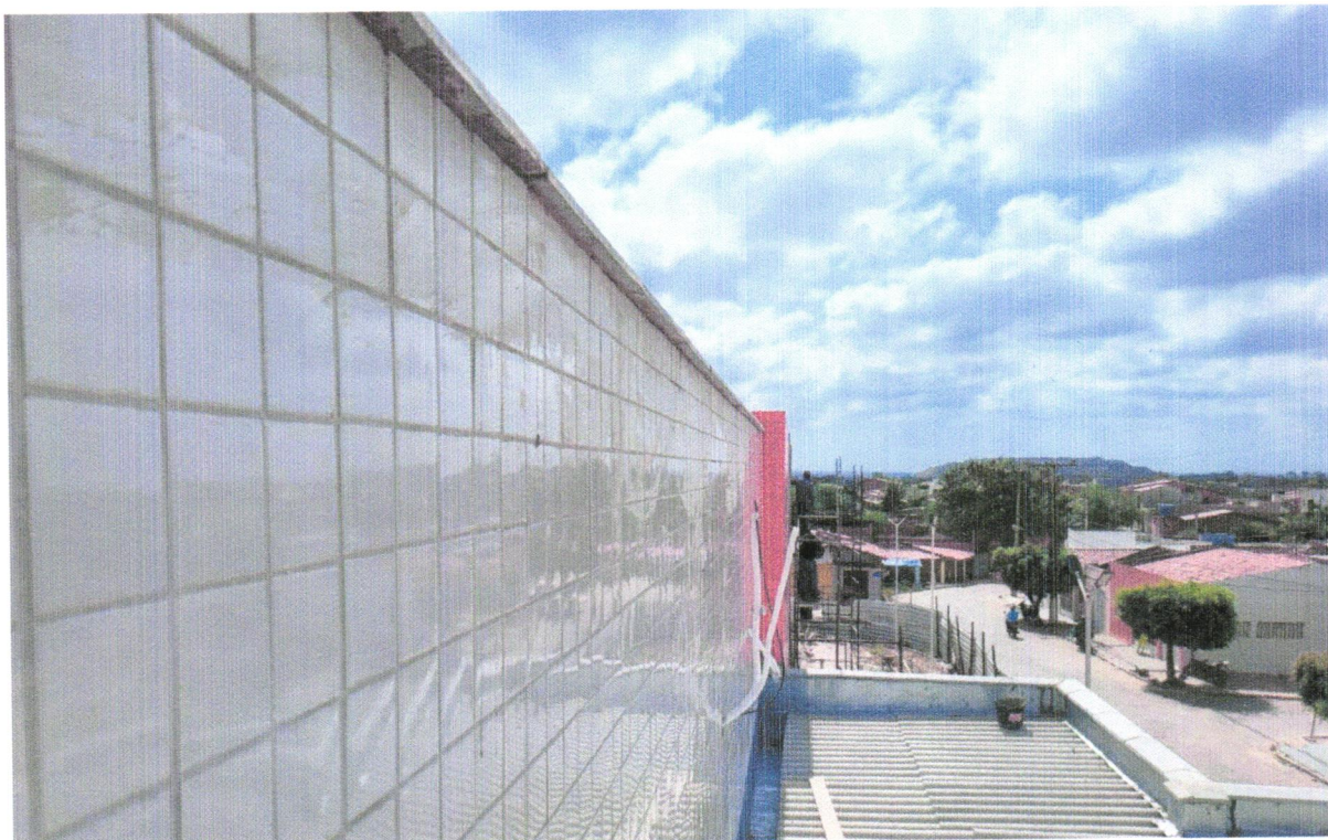
FOTO 10 - CHAPIM DE CONCRETO PRÉ-MOLDADO
