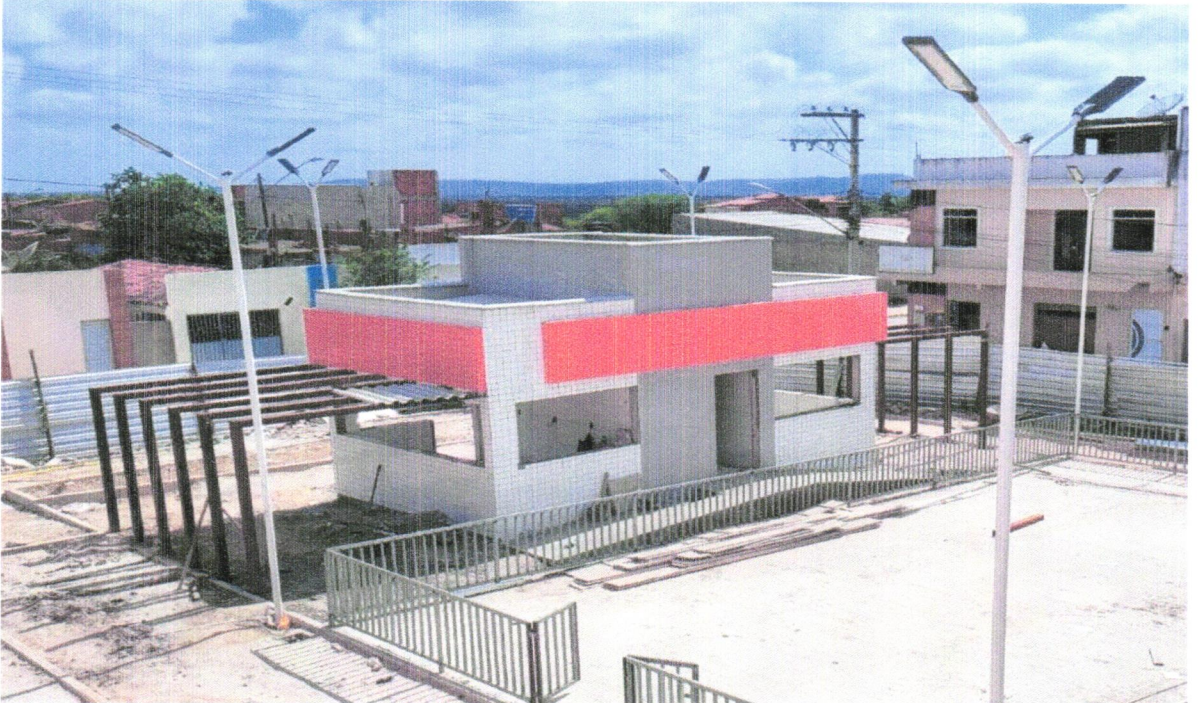
FOTO 36 - CHAPIM DE CONCRETO PRÉ-MOLDADO
