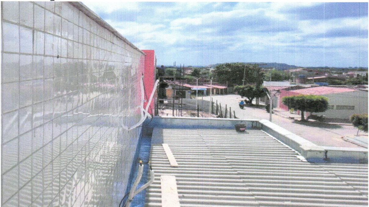
FOTO 32 - RUFO EM CHAPA DE AÇO GALVANIZADO NÚMERO 24, CORTE DE 25 CM, INCLUSO TRANSPORTE VERTICAL. AF_07/2019
