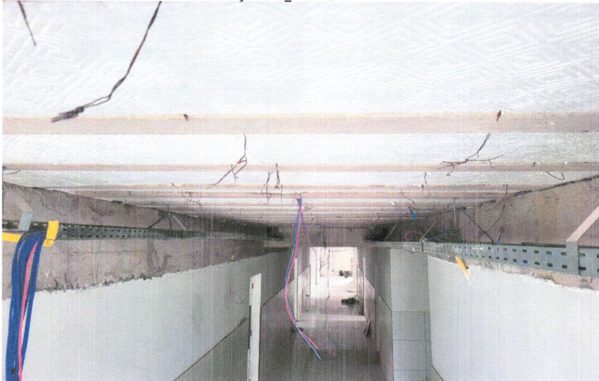
FOTO 40 - CABO DE COBRE FLEXÍVEL ISOLADO, 2,5 MM 2 , ANTI-CHAMA 450/750 V, PARA CIRCUITOS TERMINAIS - FORNECIMENTO E INSTALAÇÃO. AF_12/2015
