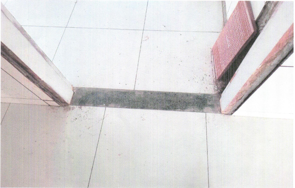
FOTO 16 - SOLEIRA EM GRANITO, LARGURA 15 CM, ESPESSURA 2,0 CM. AF_09/2020
