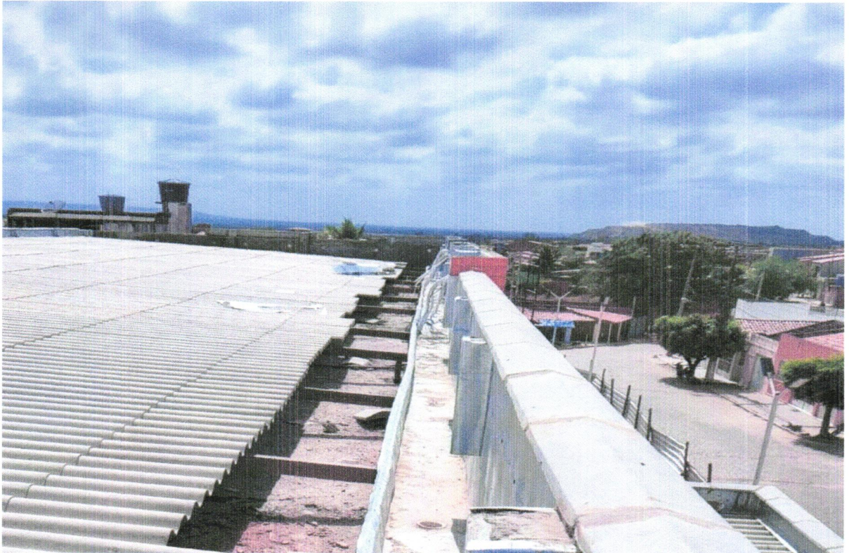
FOTO 32 - RUFO EM CHAPA DE AÇO GALVANIZADO NÚMERO 24, CORTE DE 25 CM, INCLUSO TRANSPORTE VERTICAL. AF_07/2019
