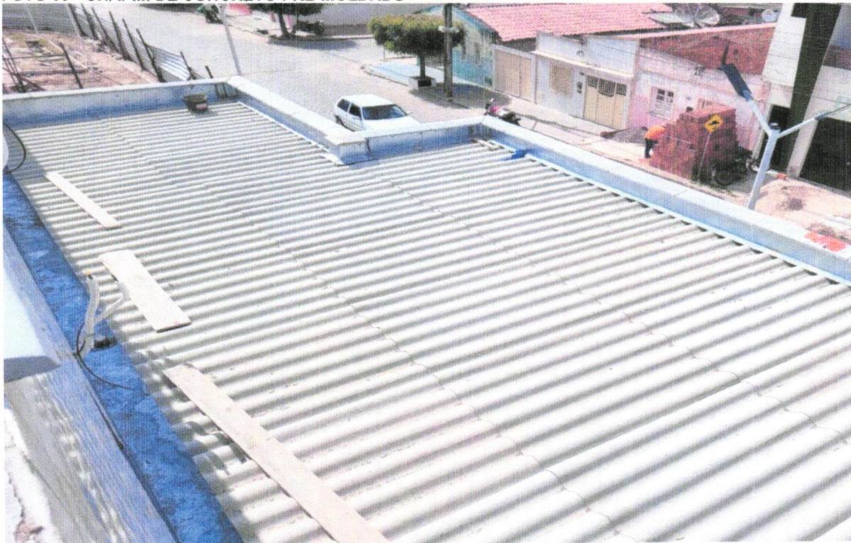
FOTO 10 - CHAPIM DE CONCRETO PRÉ-MOLDADO
